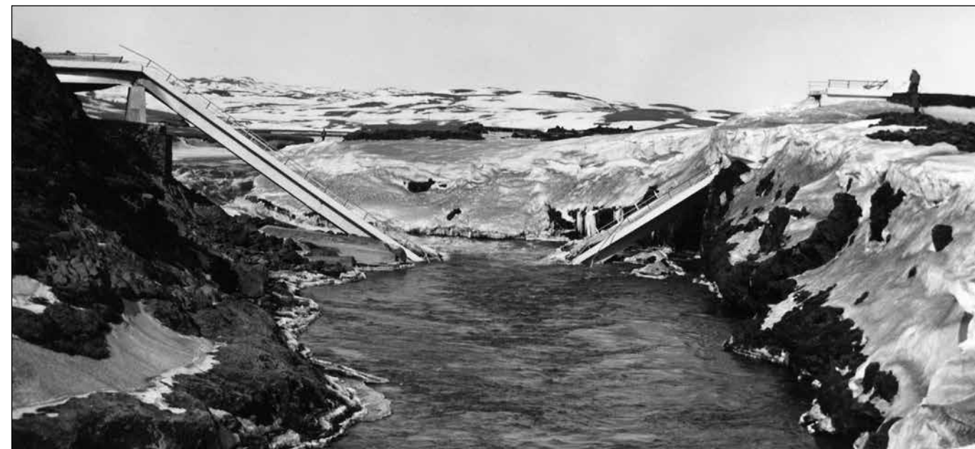
Brú yfir Eldvatn hjá Ásum sem Helgi segir frá. Brúin var byggð 1965 með miðstöpli sem stóð á hraundrangi í miðjum árfarveginum. Í miklu hlaupi í nóvember 1966 hvarf þessi drangur og stöpullinn með. Einnig gróf undan stöpli á austurbakkanum. Leifarnar af brúnni löfðu uppi í tæpa þrjá mánuði en síðan féll hún.
