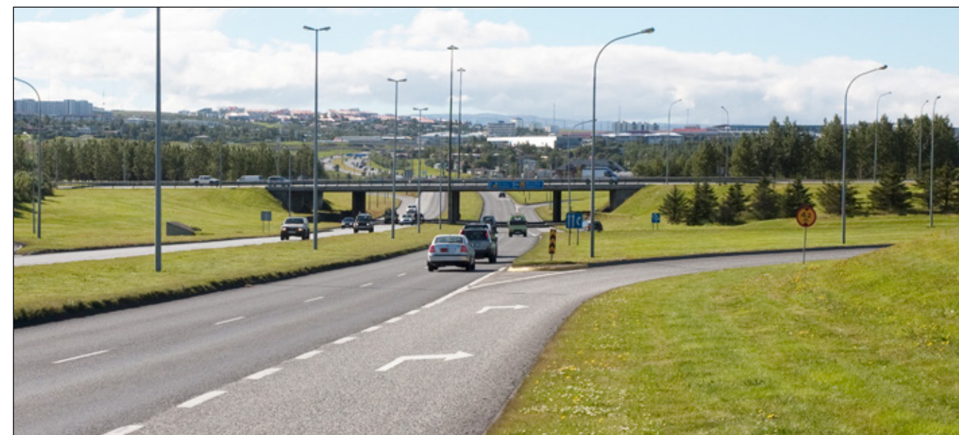
Nýjar áskoranir brúaverkfræðinga á sjöunda áratugnum voru umferðarbrýr. Þær þurftu að vera með plötum eða lágum en breiðum burðarbitum. Mislæg gatnamót Miklubrautar og Reykjanesbrautar. Syðri brúin var byggð 1970.
