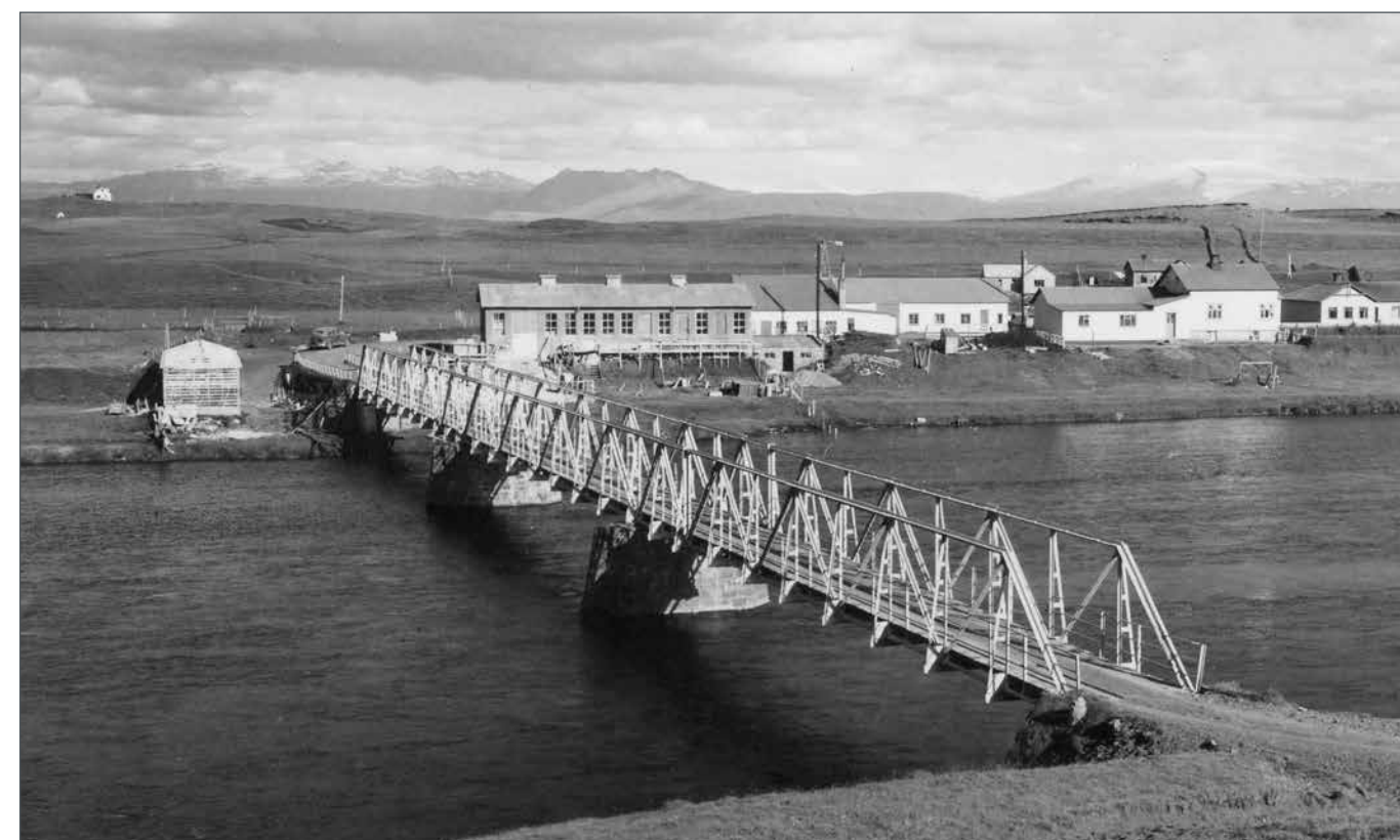
Ytri Rangá hjá Hellu. Þegar Helgi er að hefja störf við brúahönnun eru svona grindarbitar á undanhaldi. Efnismeiri stálbitar (I-bitar) og spennsteypa tekur við.
