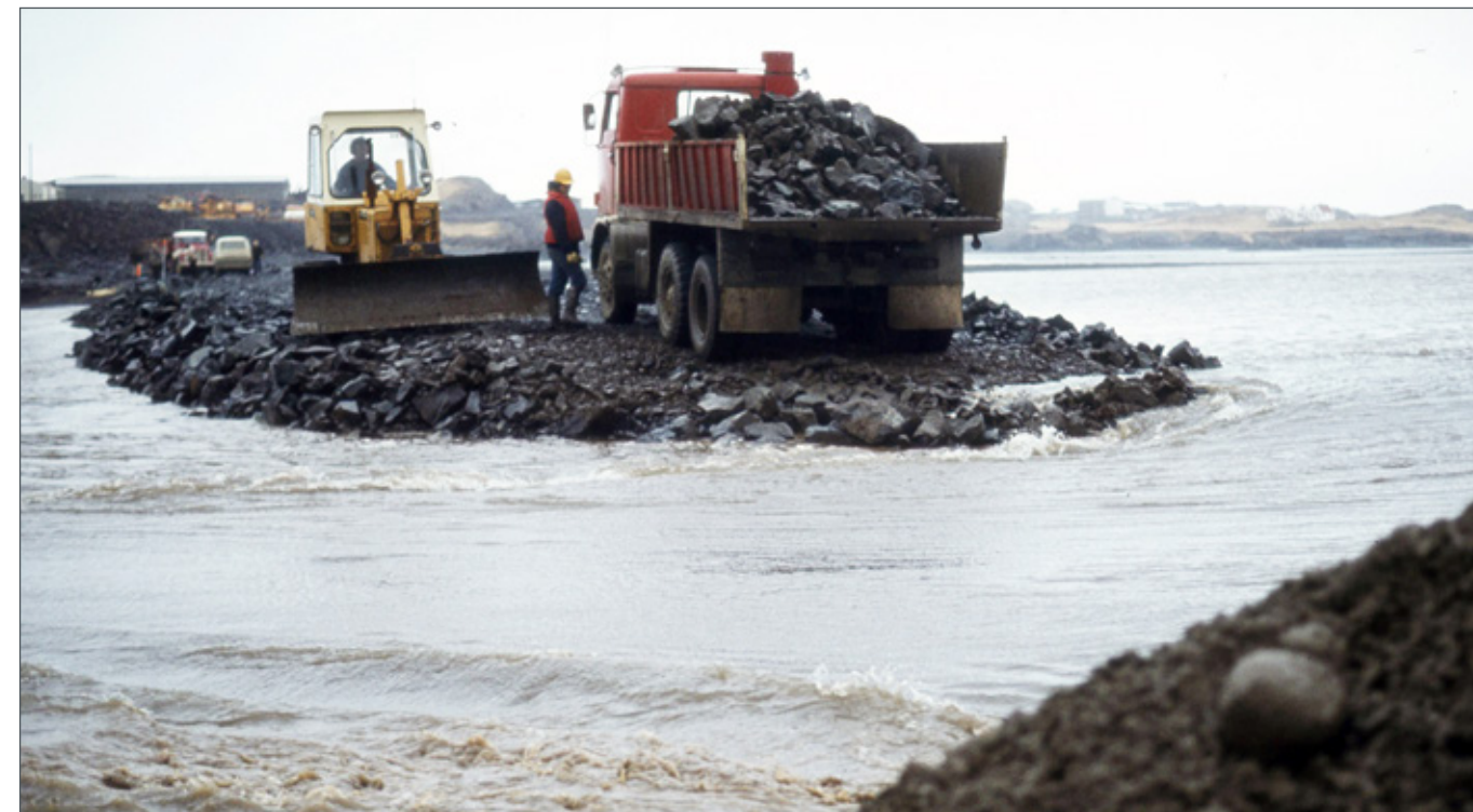
Fyllingunni í Borgarfirði lokað. Að ósk ráðherra voru eingöngu heimabílar í þessu verki en á móti lofuðu þeir hámarksafköstum og stóðu við það.
