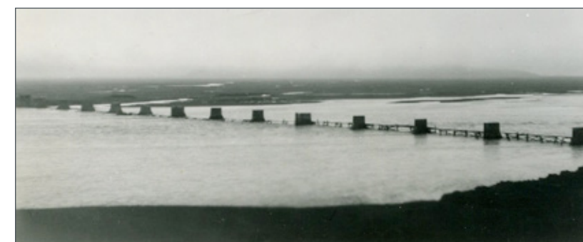
Jökulsá í Lóni brú í byggingu 1952.
