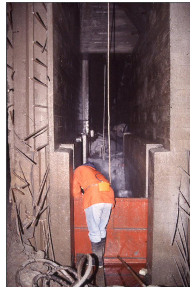
Breiðadals- og Botnsheiðargöng. Byggður var skápur til að hemja vatnsrennsli og beina því í fráveitu. Á myndinni er Björn Harðarson eftirlitsverkfræðingur að mæla vatnsmagn.
