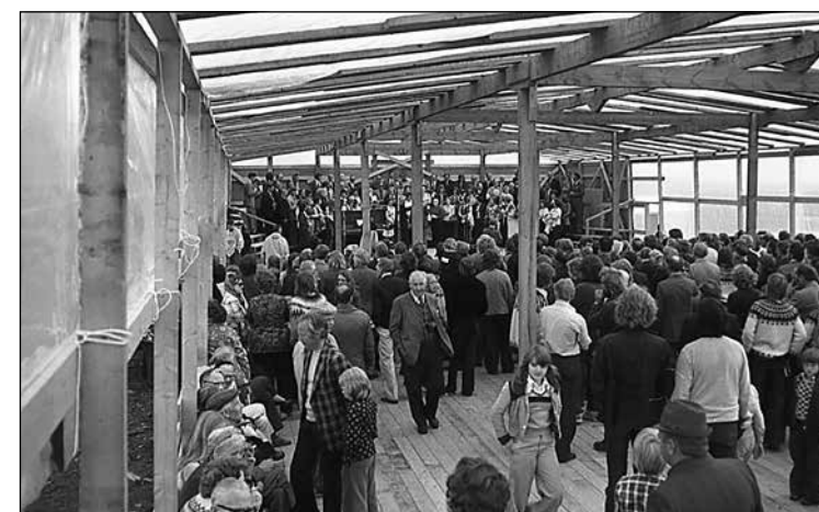
Skýli vegna vígslunnar á Skeiðarársandi, trégrind klædd plasti. Það varð mikill hávaði þegar það gerði skúr í miðri athöfn og regnið buldi á plasinu.
