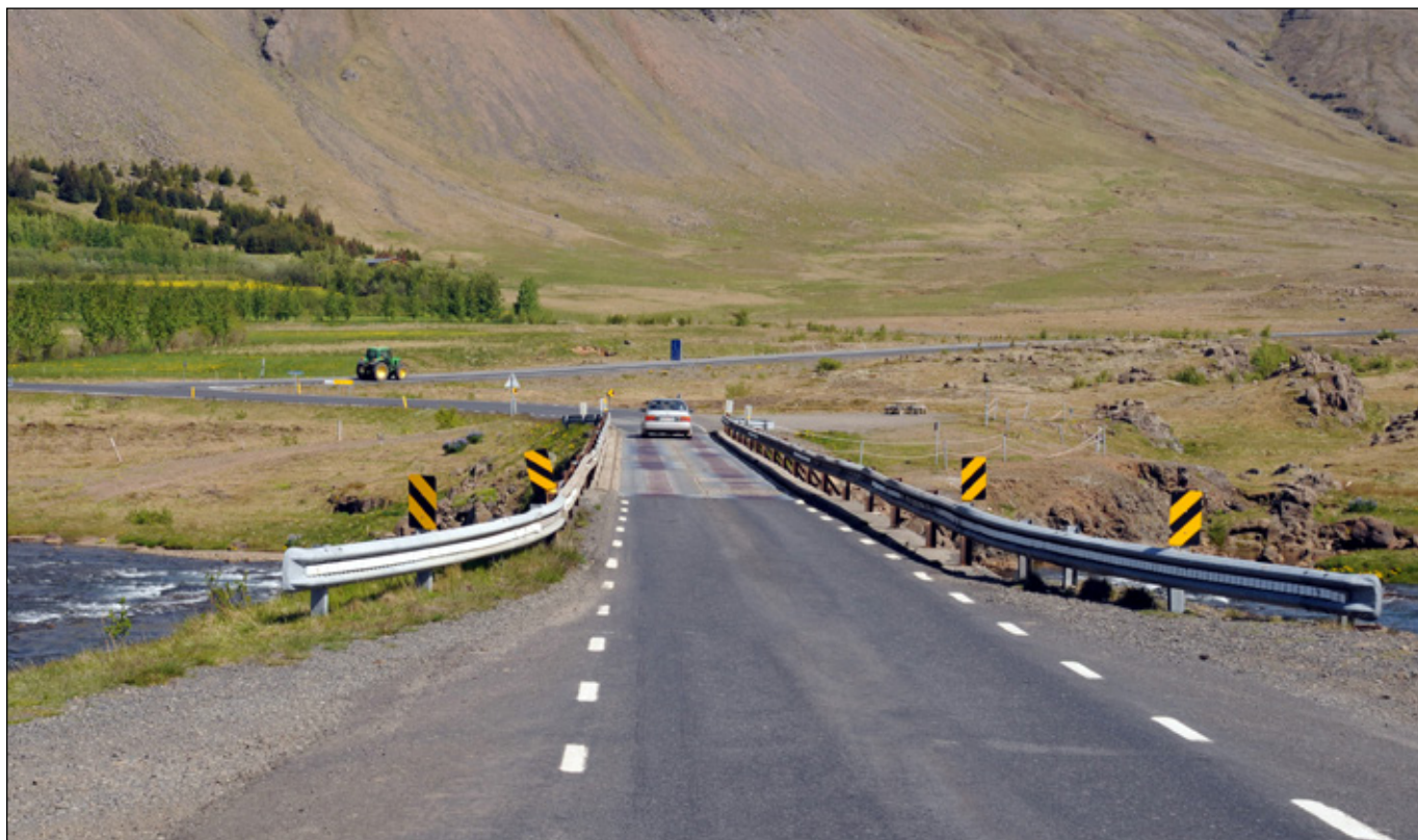
Einbreið brú yfir Laxá í Kjós.
