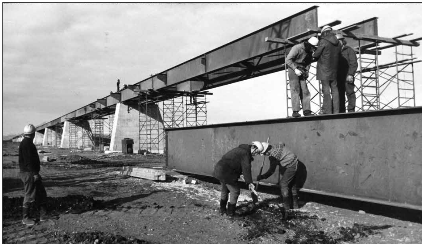
Brúagerð á Skeiðarársandi. Einfaldar stálbitabrýr með timburgólfi.
