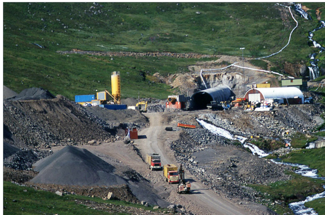
Breiðadals- og Botnsheiðargöng. Gangamunni í Tungudal. Fyrir neðan gangamunnann má sjá hvar vatn úr jarðgöngunum streymir í miklu magni út úr röri.
