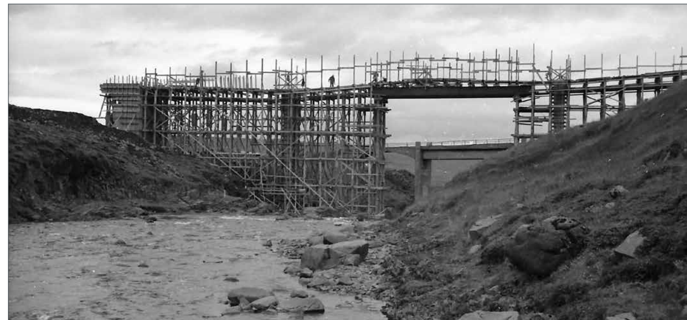
Brúin á Síká í Hrutafirði, byggð 1970, var síðasta einbreiða brúin á leiðinni á milli Reykjavíkur og Akureyrar. Hún stendur enn á tengivegi en aðalleiðin, Hringvegur (1), var færð talsvert norðar með nýrri brú árið 2008.
